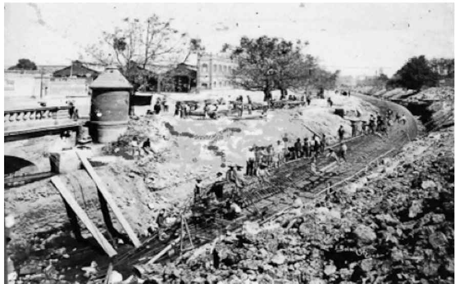
Imagen 1 (izquierda). El río San Juan de Dios (circa 1900) antes de ser entubado y transformado en el Paseo Porfirio Díaz, hoy Calzada Independencia. Tomada de guadalajaraayeryhoy.blogspot.mx . Imagen 2 (derecha) entubamiento del río del mismo nombre (circa 1909). Tomada de guadalajaraayeryhoy.blogspot.mx .
