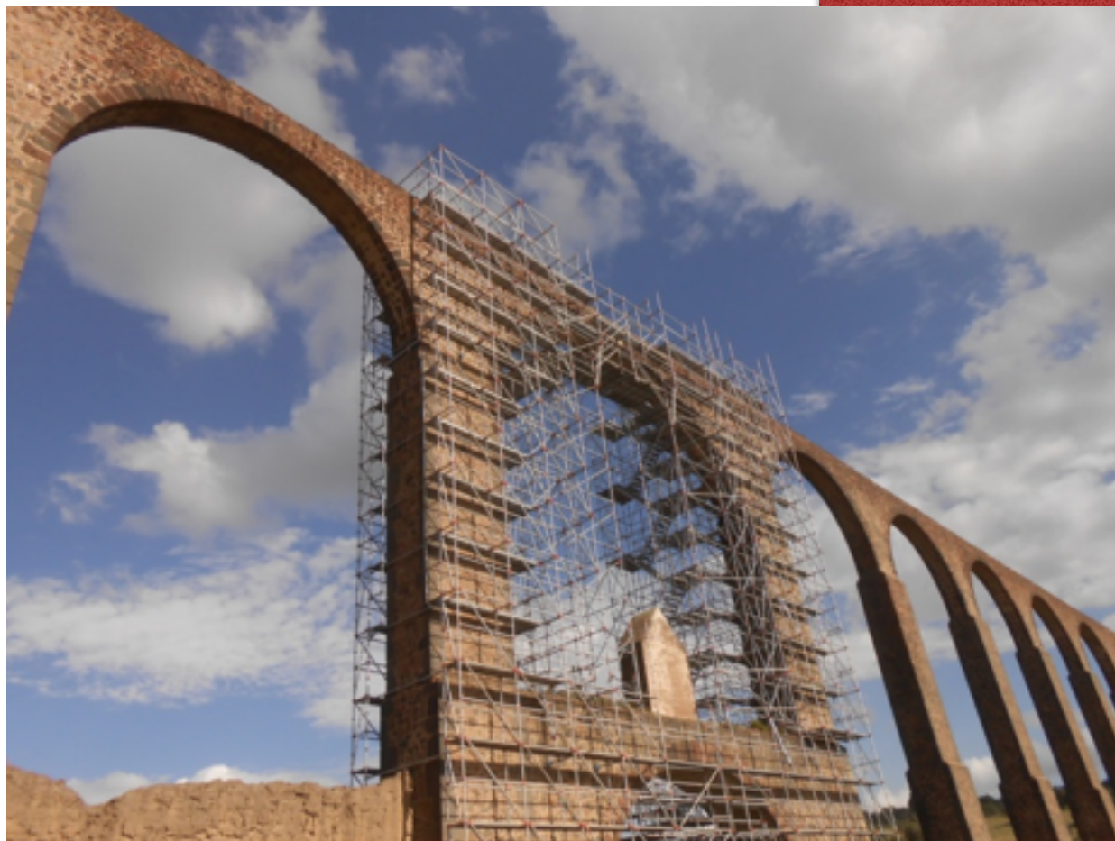
Imagen 11. Aspecto de los trabajos de restauración de la parte central de la arquería. (cortesía del Autor)
