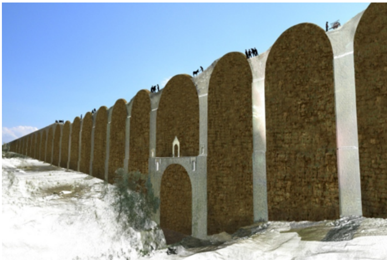
Imagen 13. La cimbra de adobe de forma semicircular, creada con seguridad a partir de un eje y un cordel desde el punto medio de los muros de adobe, a la altura de la parte superior de las pilastras, facilitó el acomodo de dovelas. Unidad de Apoyo Tecnológico de la Coordinación Nacional de Monumentos históricos del INAH. (Cortesía del autor)
