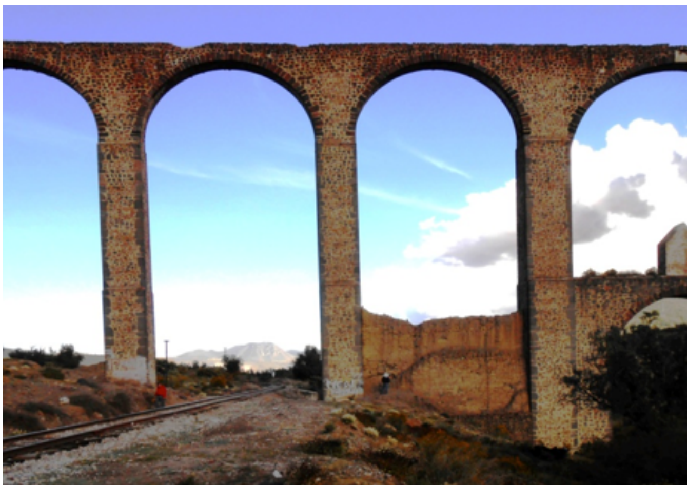
Imagen 15. Arquería Mayor de Tepeyahualco. En la parte inferior de los arcos aparecen los restos de la enorme cimbra de tierra cruda utilizada de manera audaz por Tembleque y sus colaboradores indígenas para levantar la esbelta arcada.
