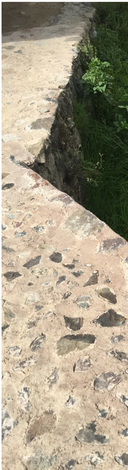
Acercamiento mezclas constructivas originales. Acueducto Tembleque. Graciela Mota
