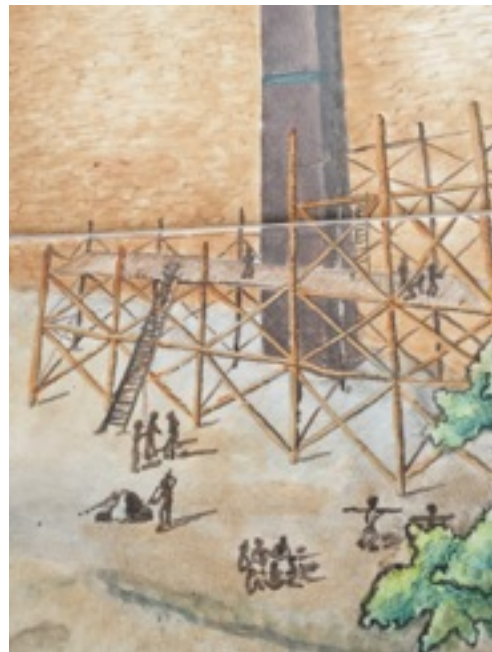
Fragmento del mural dedicado al padre Tembleque, andamiaje de la construcción Foto: Acervo de la Dra. Graciela Mota
