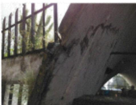
Punto de fractura de uno de los cañones parabólicos. Causando una contraflecha aproximada de 25 cm.
