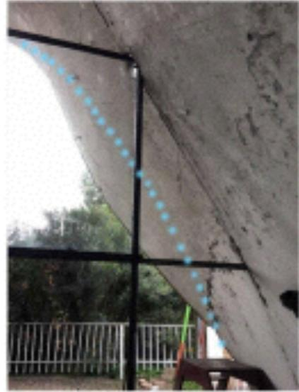
El inmueble prácticamente se partió en dos, esto derivado del sismo de septiembre del 2017. La línea punteada en azul representa la geometría original del cañón, a punto de colapsar. También se detecta la perforación de las losas por la cancelería.
