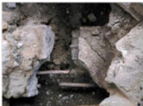
Rompimiento de la liga perimetral que une las zapatas aisladas, provocando que éstas tengan un desplazamiento hacia el exterior.
