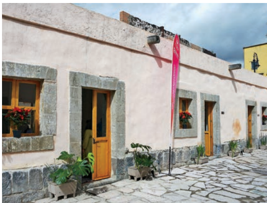
RENOVACIÓN. Limpiaron la cantera, las gárgolas y agregaron la carpintería.
