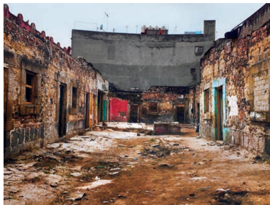
SUELO NUEVO. El patio había perdido su pavimento original y tuvo que ser restituido por completo.
