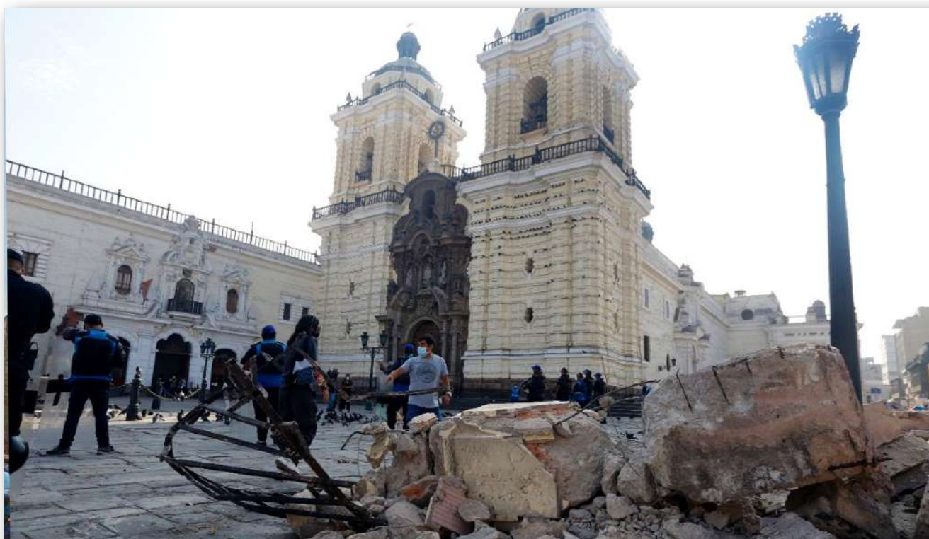
Al detonar la destrucción de la barda perimetral también se puso en riesgo la estructura del inmueble como del subsuelo en el que se han encontrado antiguos restos del S. XVII al XIX. Fotografía de Félix Contreras.
