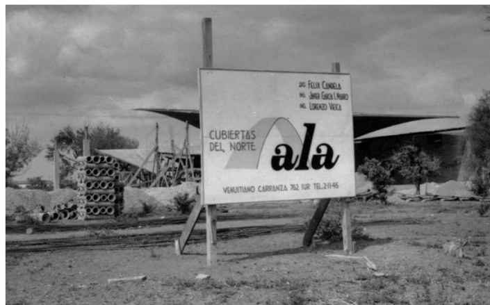
Anuncio de Cubiertas Ala del Norte en una obra, Monterrey, Nuevo León. Foto: Colección Fernando García S. Narro.
