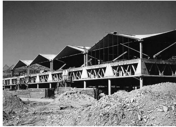
Edificio sede de la Texas Instruments Semi-Conductor Components, Richardson, Texas, durante la construcción. Se aprecia el nivel inferior del suelo, el espacio intersticial para instalaciones y los cascarones de concreto armado en la cubierta, 1958. O'Neil Ford & Associates (Richard Colley, Arch Swank y Sam Zisman), consultor estructural: Félix Candela. Dillon, David, The Architecture of O'Neil Ford, Celebrating Place .
