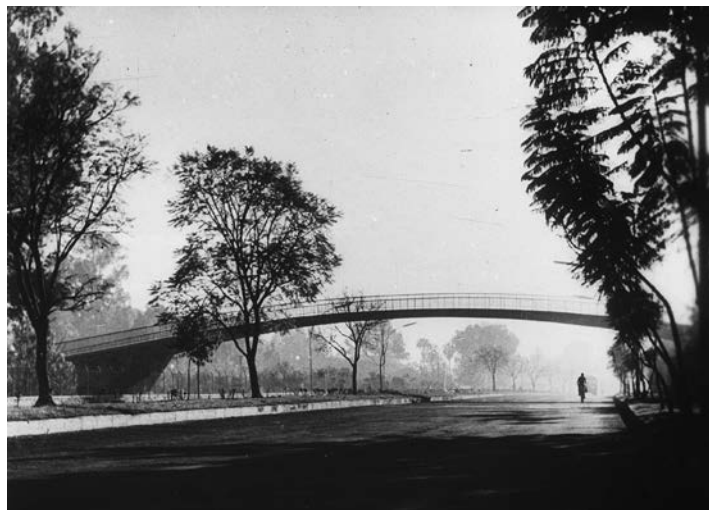
Parque Agua Azul, puente sobre la Calzada Jesús González Gallo. Foto: Archivo Alejandro Zohn.
