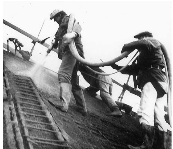
Trabajadores de Ulrich Müther en el proceso Torkret. Foto: © Müther-Archiv.
