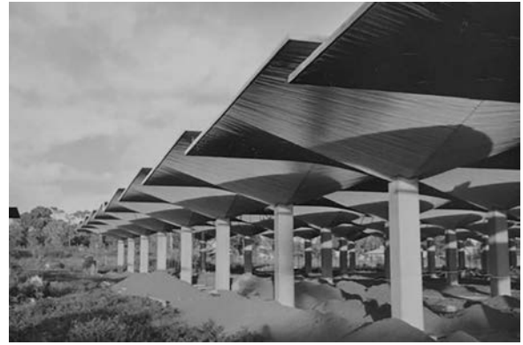
Mercado en construcción, Guatemala, 1961-1966. Foto: Archivo Castillo Gallusser.
