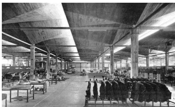
Planta Ensambladora Volkswagen Palma Sola, Morón, Venezuela, 1962. Arquitectos: Dirk Bornhorst y Pedro Neuberger. Láminas parabólico-hiperbólicas: Cubiertas Ala de Venezuela / Félix Candela, Álvaro Coto y José Gabriel Loperena. Constructora: STAR. Foto: Informes de la Construcción , vol. 18, núm. 177.
