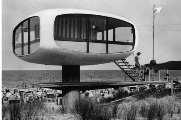
Torre de rescate del lado oeste para los salvavidas, en Binz, isla de Rügen, 1975. En construcción y antes de su demolición en 1993. Fotos: ©Müther-Archiv.
