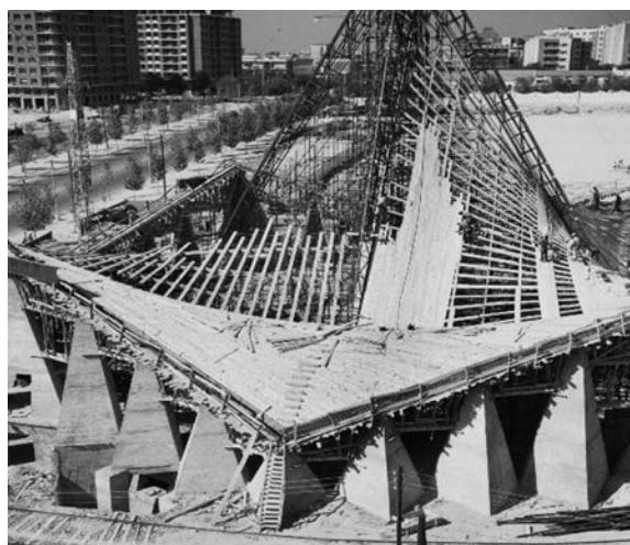
Santuario de Nuestra Señora de Guadalupe, en Madrid, durante la construcción de la cimbra (encofrado). Foto: Archivo Arquitectos Mexicanos, FA/UNAM, fondo Enrique de la Mora, exp. 278.
