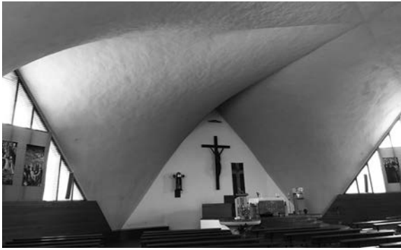
Jaime Carceller y Construcciones Laminares, iglesia de Nuestra Señora del Faro, en Cueto, Santander. Vistas exterior e interior tras la restauración. Fotos: Juan Ignacio del Cueto.
