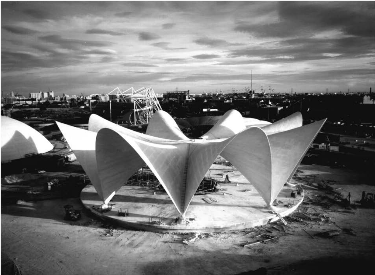
El cascarón, ya descimbrado, antes de colocar el cerramiento. Foto: FCC-ACS-Sedesa.
