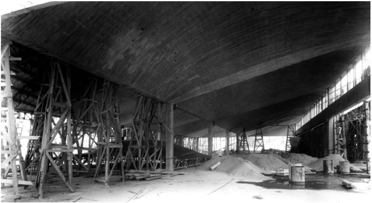
Ovidio Botella (TASA), bodegas para la planta industrial Círculo Perfecto, con cimbras móviles. Foto: Archivo familiar Botella Campos.
