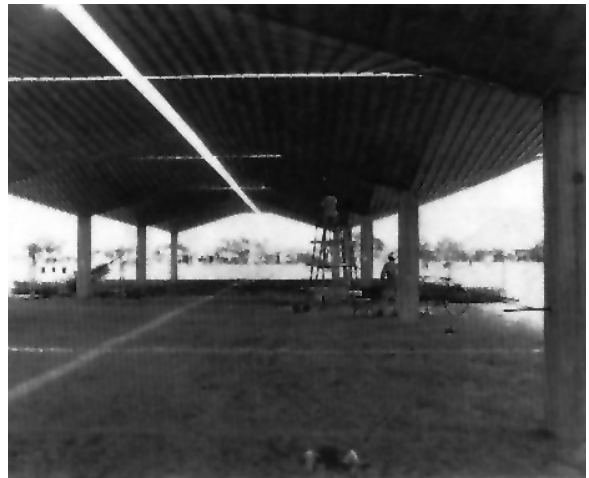
Paraboloide hiperbólico encofrado metálico, Venezuela. Arquitecto: Álvaro Coto. Fuente: Archivo de Álvaro Coto Asenjo. Foto: cortesía de la arquitecta Carolina Coto.
