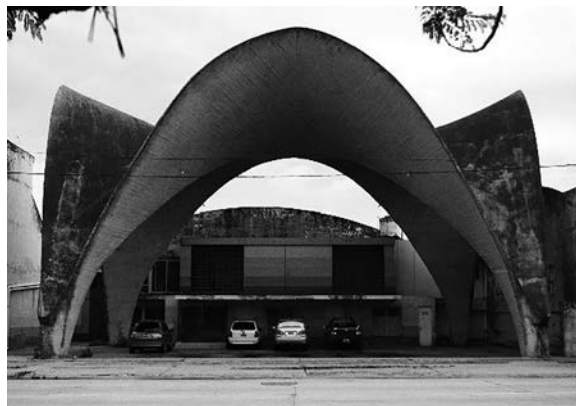
Concesionaria de automóviles Angeletti, San Francisco, Córdoba, Argentina, arq. Macchieraldo, 1964-1967. En construcción (arriba). Foto: Archivo Gráfico y Museo Histórico de San Francisco. Estado actual (abajo). Foto: Gonzalo Fuzs.
