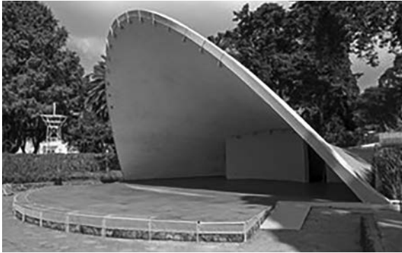
Concha acústica, Parque de la Industria, Ciudad de Guatemala, 1960. Cimbra durante su construcción y estado actual. Fotos: Archivo Castillo Gallusser y José Mata.
