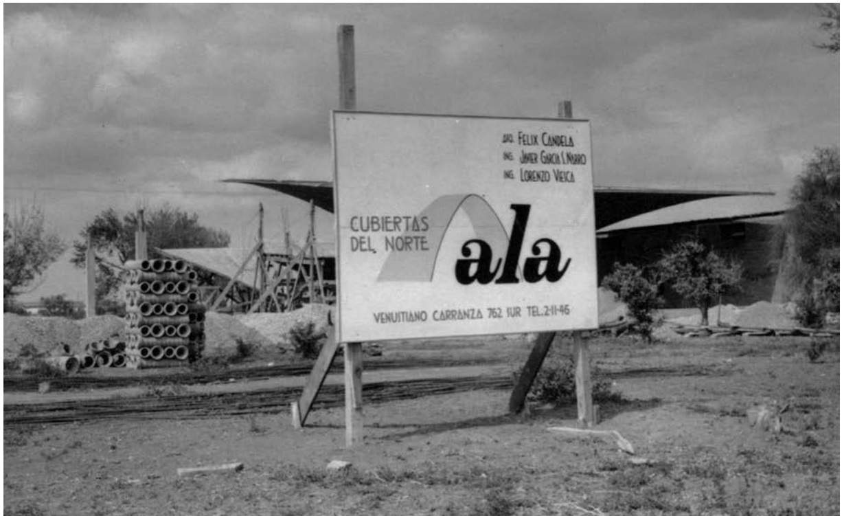
Anuncio de Cubiertas Ala del Norte en una obra, Monterrey, Nuevo León. Foto: Colección Fernando García S. Narro.
