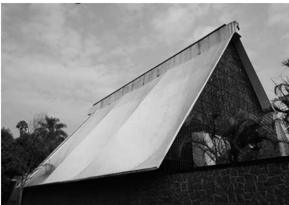
Iglesia de Nuestra Señora de Guadalupe, en El Rosedal. Arriba, esquema estructural que muestra los tres pares de paraguas inclinados y enfrentados entre sí, con las dos traveses rigidizantes en el borde superior (una por cada hilera de paraguas); al centro, durante el proceso constructivo. Dibujo y foto: Archivo Alberto González Pozo. Abajo, vista exterior. Foto: Juan Ignacio del Cueto.
