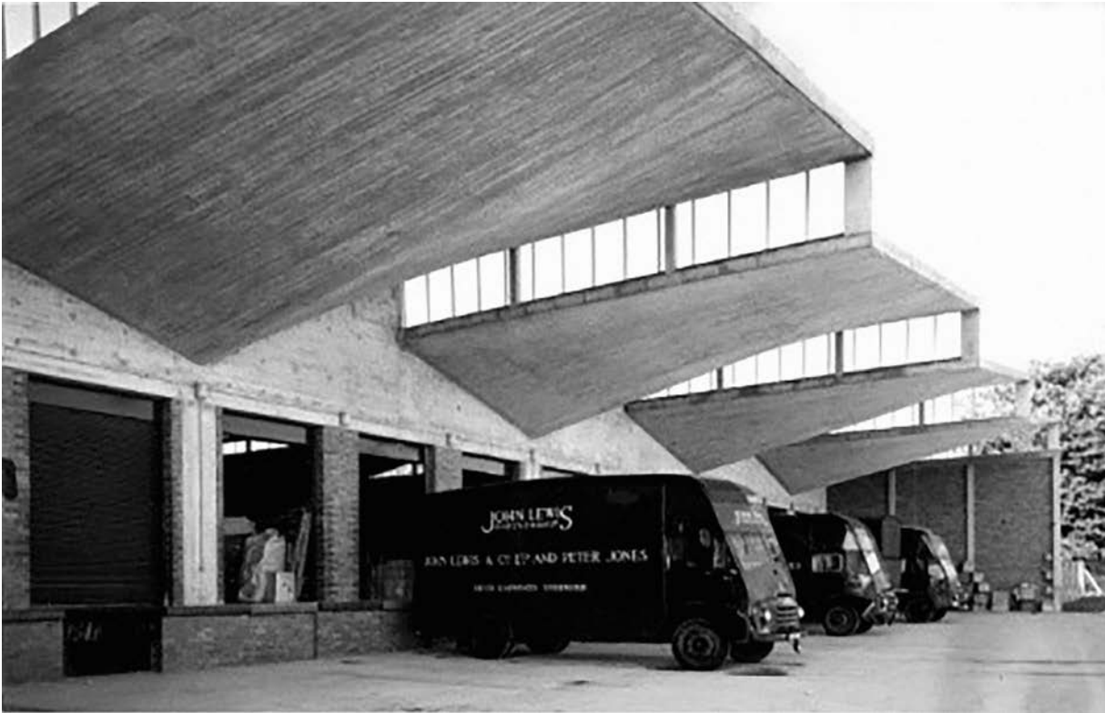
YRM (Yorke, Rosenberg & Mardall) con Félix Candela, consultor estructural. Almacén y Centro de Distribución John Lewis, en Stevenage, Gran Bretaña. Foto: John Lewis Archives, Stevenage.
