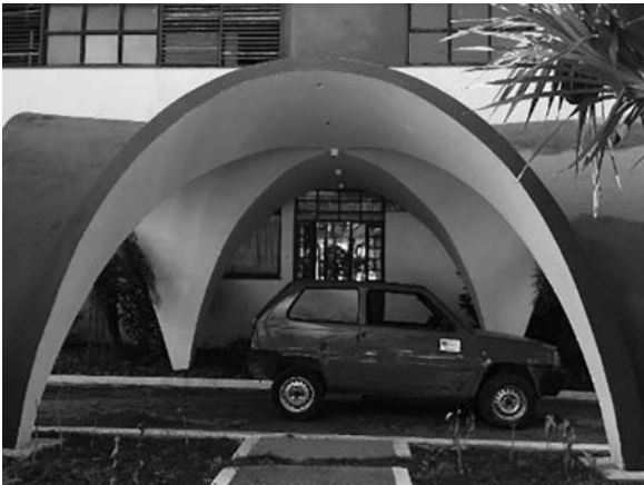
Otros ejemplos de cascarones de concreto en la isla: bungalow en una playa al este de La Habana, y cubierta a la entrada de la casa de Eusebio Leal, 1957. Fotos: María Garlock.
