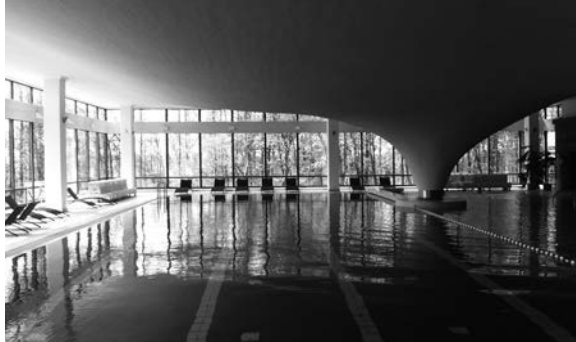
Cubierta de la alberca del Hogar CC (hoy Hotel Cliff) en construcción, y en la actualidad. Sellin, isla de Rügen, 1977. Fotos: ©Müther-Archiv.
