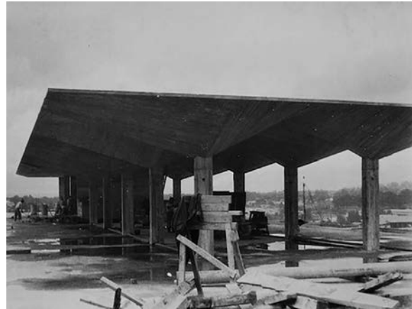
Paraguas en la azotea del Instituto Guatemalteco de Seguridad Social, Ciudad de Guatemala, 1959. Foto: Archivo Castillo Gallusser.
