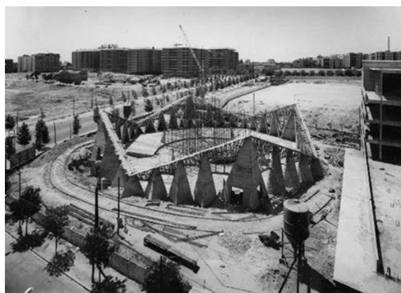
Santuario de Nuestra Señora de Guadalupe, en Madrid, durante la construcción de "La plegada". Foto: Archivo Arquitectos Mexicanos, FA/UNAM, fondo Enrique de la Mora, exp. 278.
