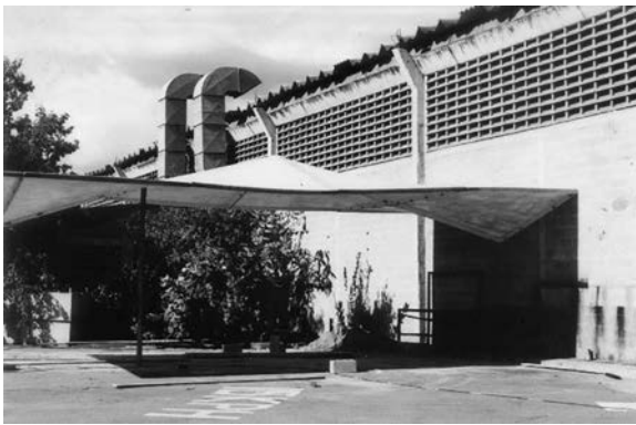
Paraboloides hiperbólicos con fibra de vidrio, Venezuela. Fuente: Archivo Álvaro Coto Asenjo. Foto: cortesía de la arquitecta Carolina Coto.
