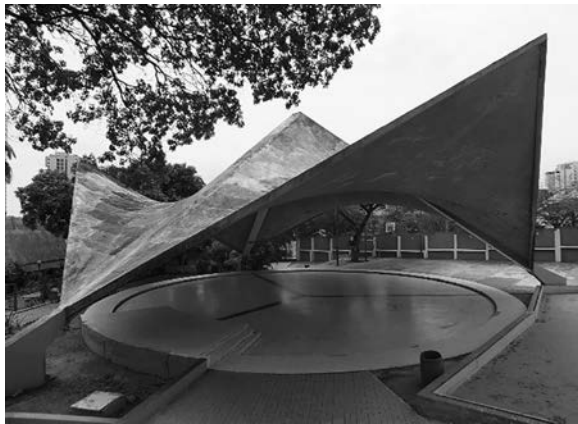
Cubierta para usos múltiples del Colegio de Ingenieros del Zulia, Maracaibo, Venezuela, 1963. Lámina parabólico-hiperbólica: Cubiertas Ala de Venezuela / Félix Candela, Álvaro Coto y José Gabriel Loperena. Foto: Arquitecto Carlos Marval. NMD NOMADAS.
