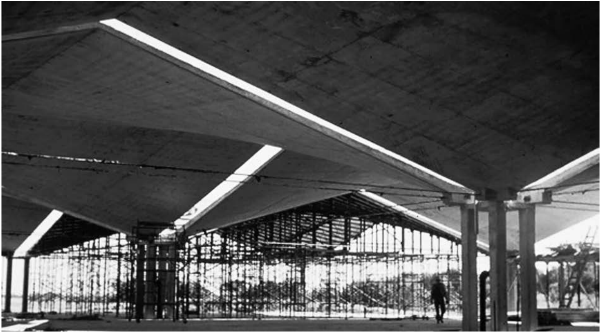
Edificio sede de la Texas Instruments Semi-Conductor Components, Richardson, Texas, espacio de trabajo flexible con sistema modular de grandes claros, durante la construcción, 1958. O'Neil Ford & Associates (Richard Colley, Arch Swank y Sam Zisman), consultor estructural: Félix Candela. Dillon, David, The Architecture of O'Neil Ford, Celebrating Place .
