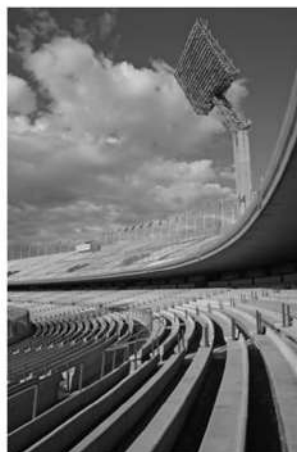
Graderías del Estadio Olímpico Universitario. Fotografía: J. B. Artigas.
