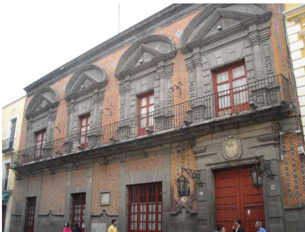
Foto 4. Casa de la Bóvedas, oficinas BUAP.
