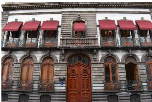
Fachada de la Casa de la Reina. Elaboración propia. Fuente: GLR.
