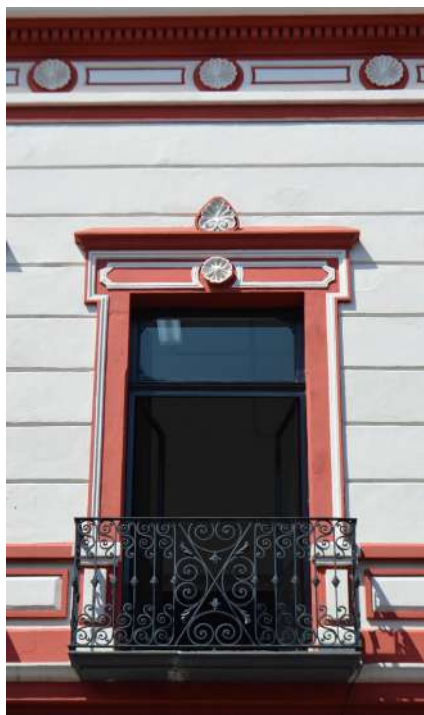
Balcón en la fachada de la Casa de los Estudiantes Hombres
