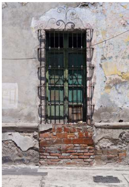
Ventana en la fachada lateral del Edificio 14 Sur, ubicado en la antigua calle de Pochas.
