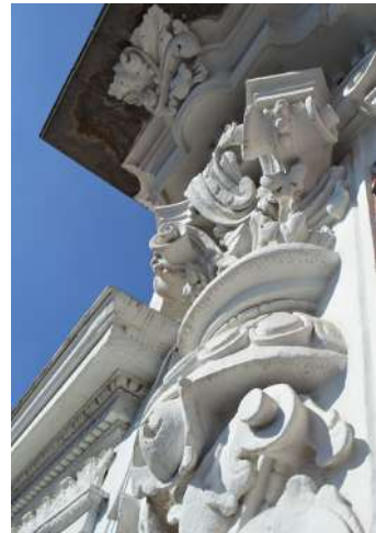
Detalle en yesería de la Casa del Capitán Munuera. Elaboración propia. Fuente: GLR
