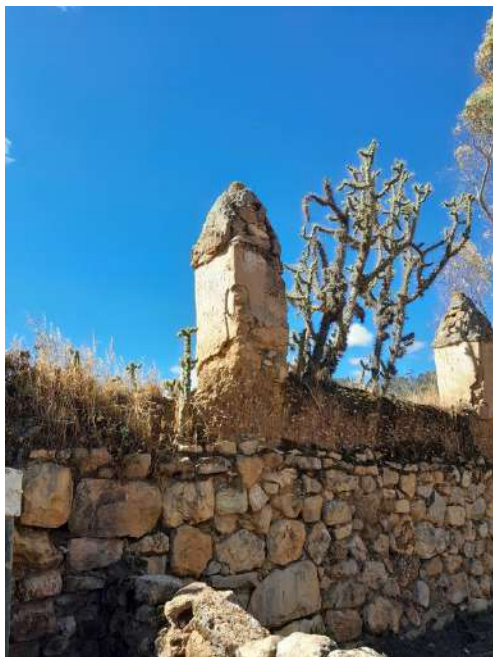
Ilustración 7. Mampostería de piedra careada, se puede observar la tapia y la almena. Lado sur (Foto: Pavel Leiva)
