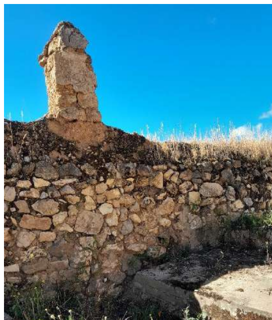
Ilustración 4. Paramento del muro perimetral del cementerio histórico, nótese el sistema constructivo similar al del sitio arqueológico. (foto: Pavel Leiva)
