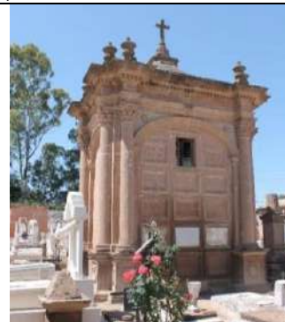
Construcción vertical aislada unifamiliar para gavetas, Panteón de Huichapan, Hidalgo, México. (EHM, 2015)
