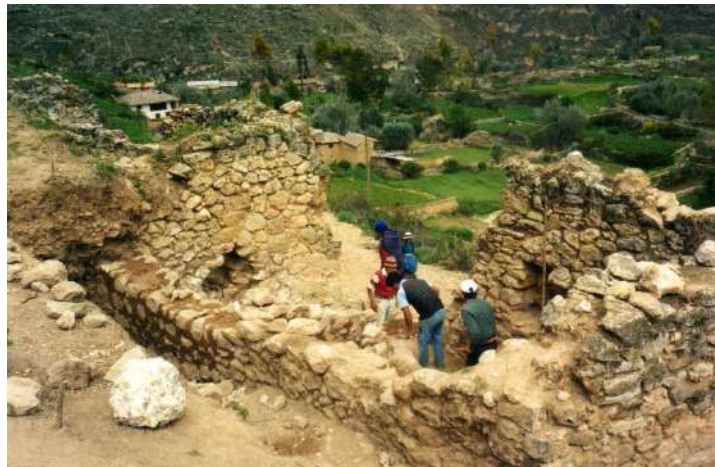
Ilustración 3. Sistema constructivo de la época prehispánica, limpieza de una collca del sitio arqueológico de Tarmatambo. (Foto: Leiva y Galicia 2003)
