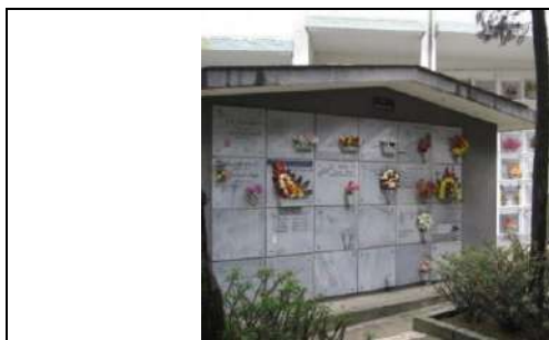
Construcción vertical aislada plurifamiliar, Cementerio San Pedro, Medellín, Colombia. (EHM, 2012)
