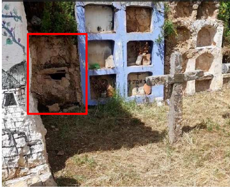
Ilustración 18. En el recuadro rojo, ubicado al costado sur de la capilla, están los nichos donde se encuentran los restos de los chilenos caídos en la batalla de 1882, según la memoria colectiva. (foto Pavel Leiva).
