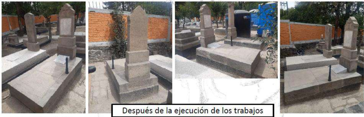
Ing. Daniel Olivera González Superintendente de Obra
