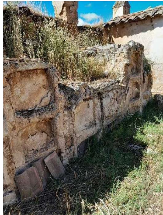
Ilustración 11. En esta imagen se puede notar el mal estado de conservación de los nichos, que son la mayoría del cementerio. (foto Pavel Leiva)
