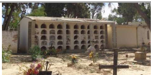
Construcción vertical aislada plurifamiliar. Cementerio de Punata, Bolivia. (EHM, 2018)
