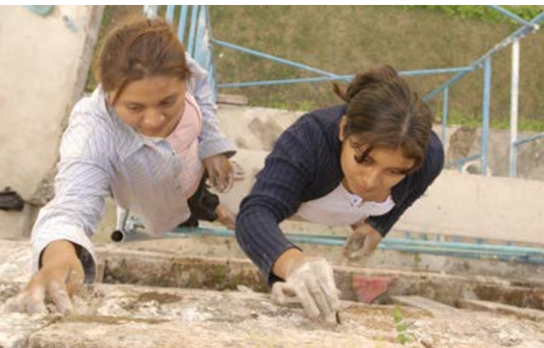
Ilustración 4. Mujeres aplicando mortero en las juntas de los sillares. Foto José Huchim.
