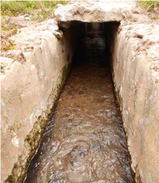
Ilustración 2. Canales abiertos que conducen el agua hacia el Acueducto.
