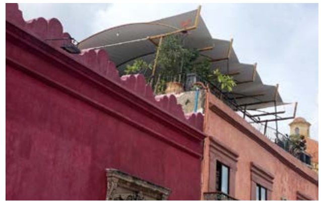
Ilustración 5. Adecuación de terrazas en cubiertas de inmuebles sin justificación y con soluciones no apropiadas ni en sentido de seguridad ni de integración al entorno.
