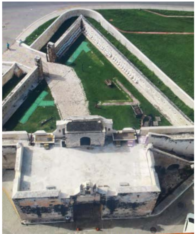
Ilustración 4. Revellín de la Puerta de Tierra. Gobierno del Estado de Campeche
