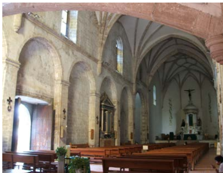
Ilustración 6. Templo de Santo Domingo de Oaxtepec. Interior, trazado en una planta y crecimientos de crucero, destacan las bóvedas de nervaduras.
