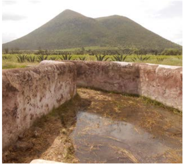
Ilustración 4. Ejemplo de un jagüey sucio con pasto, provocando la contaminación del agua almacenada.
